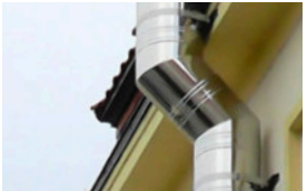
Versatzstück auf Maß gefertigt für 500 mm Achsversatz
