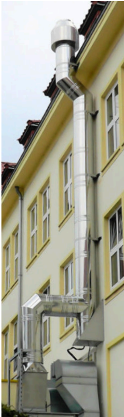
Versatzstück auf Maß gefertigt für 500 mm Achsversatz
